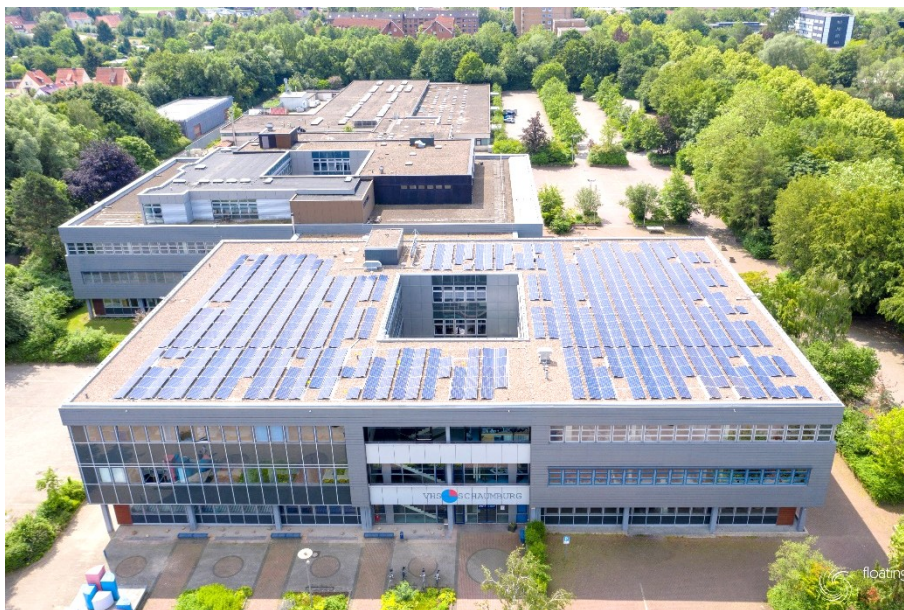
Bild 60: Solaranlage auf dem Schuldach
